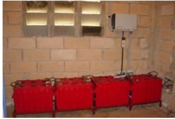
Les batteries emmagasinent l'énergie, afin que l'école dispose d'un réseau électrique autonome.
